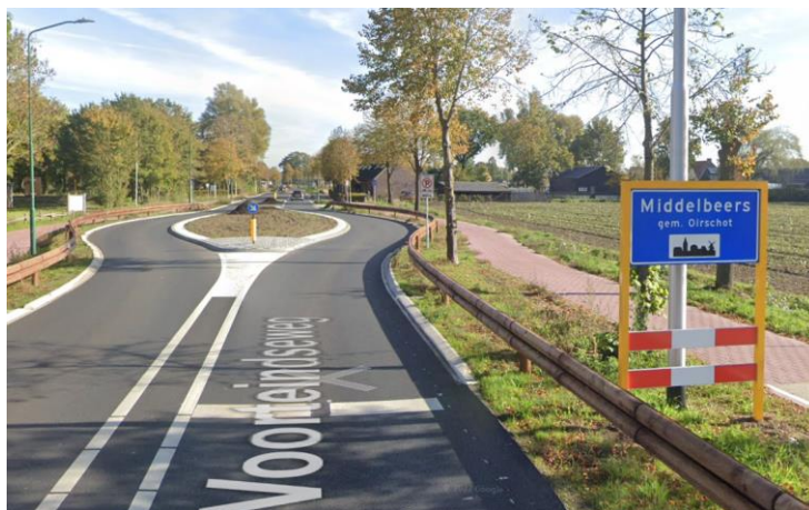
Afbeelding 16: Vooraanzicht middengeleider. Verkeer is gedwongen om uit te buigen.
