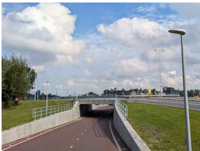
Nieuwe situatie bij het Hemponplein (tussen secties 1 en 2)
