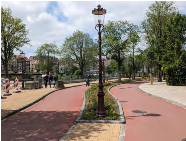
doorfietsroute Weesperzijde, sectie 10b
