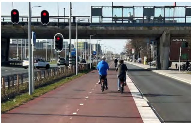
nieuwe doorfietsroute bij Kruisweg De Hoek in Hoofddorp
