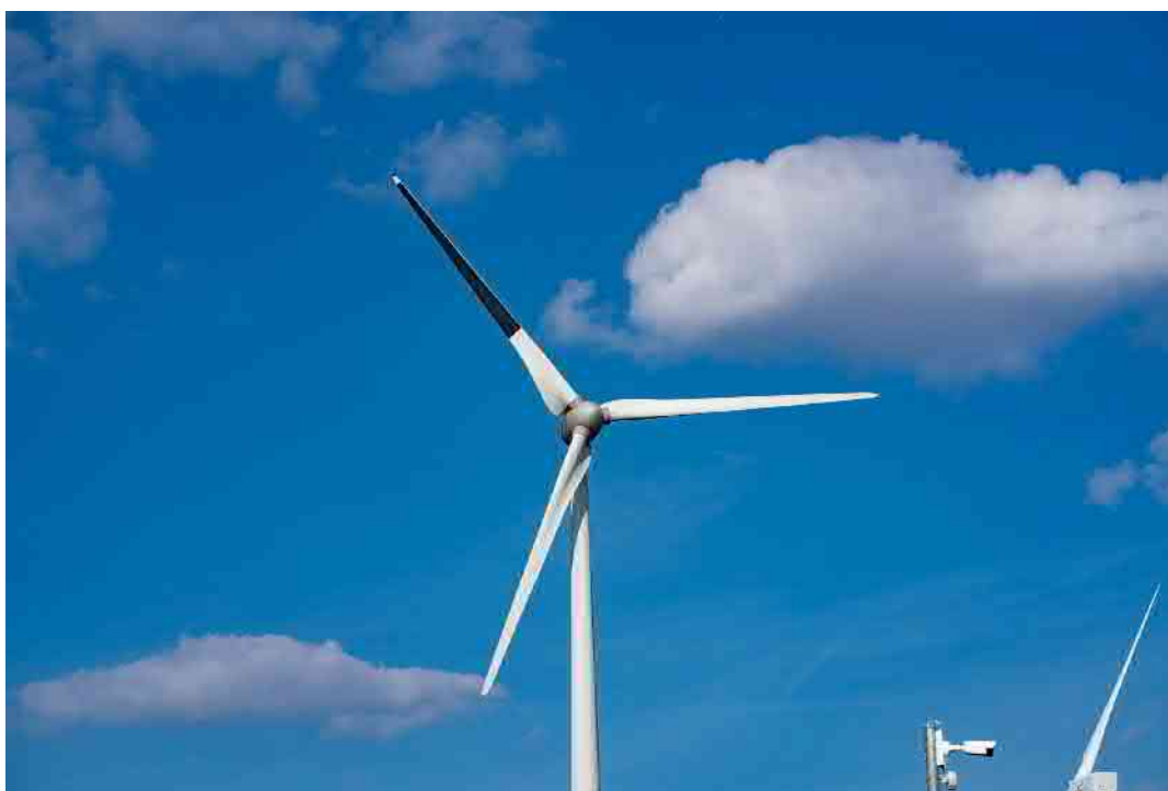
Figuur 2.1 Windturbine met zwarte wiek (foto: RWE). Het eerste deel van de wiek dicht bij de gondel (ca. 30%) en de bewegende delen (punt) van de wiek zijn niet geverfd.
