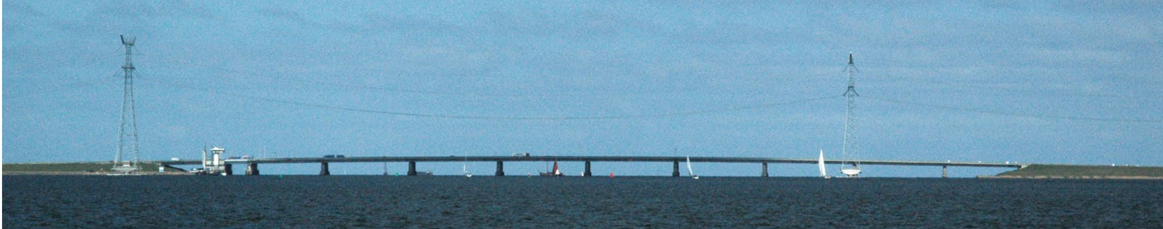
Ketelbrug | Dronten – Noordoostpolder | 1970
