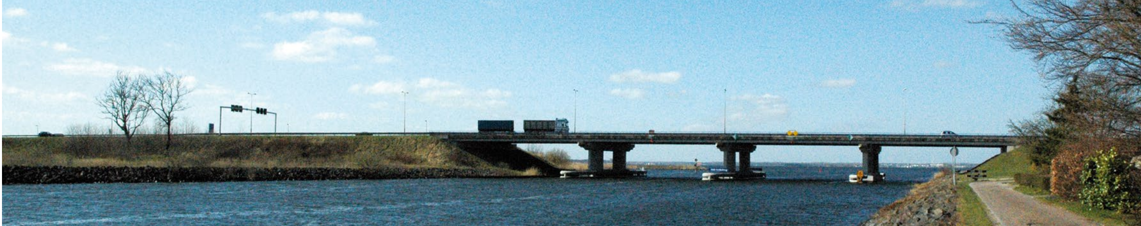
Harderbrug | Zeewolde – Harderwijk
