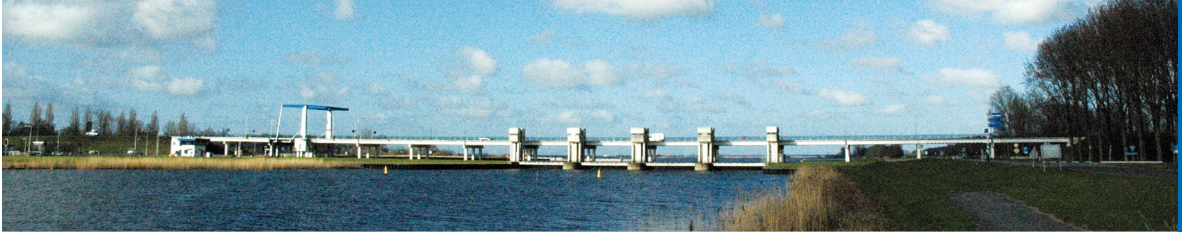
Nijkerkerbrug | Zeewolde – Nijkerk
