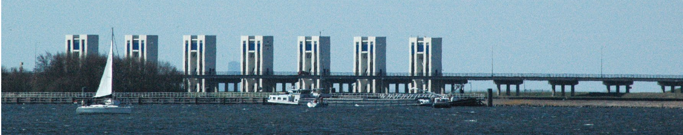
Houtribbrug en -sluis | Lelystad – Enkhuizen | 1975
