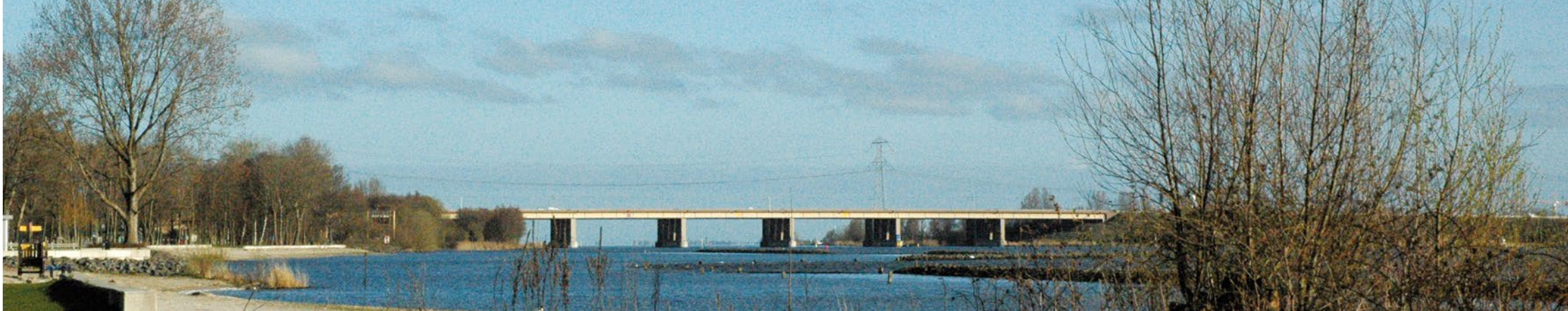
Hollandse Brug | Almere – Muiden | 1969
