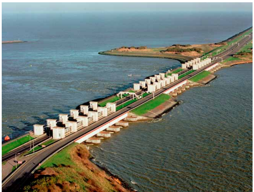
Water spuien bij de Stevinsluizen in de Afsluitdijk.
