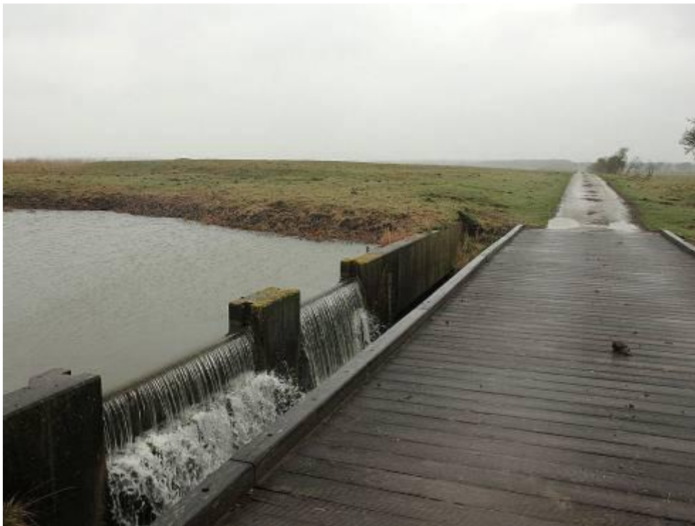
Foto 33. Vaste stuwpeilen, zoals hier bij deze stuw in de Kitstocht, Oostvaardersplassen, zorgen ervoor dat waterafvoer abrupt stopt als het waterpeil onder het stuwpeil zakt. In natuurlijke systemen blijft vaak nog langdurig een beetje water uitstromen. V-vormige stuwen benaderen de natuurlijke afwatering daardoor beter.
