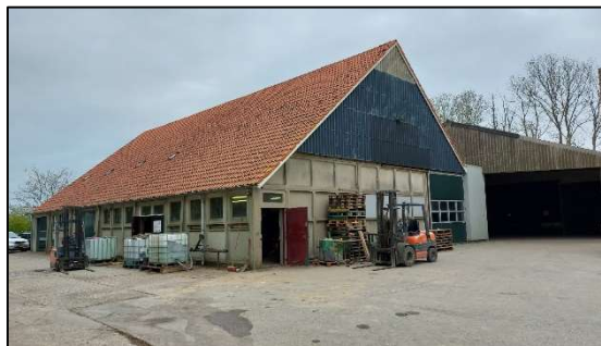
Afbeelding 2.3. Meest noordelijk gelegen schuur met gekoppelde schuur rechts.
