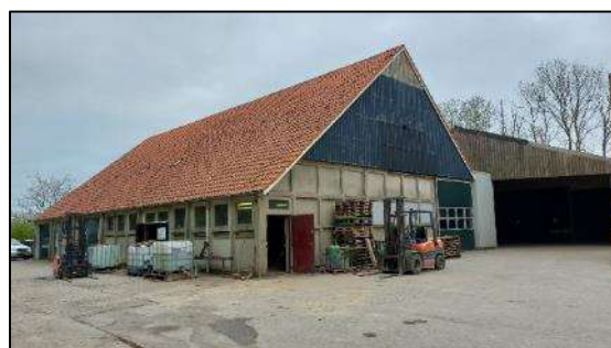
Afbeelding 1.2. Meest noordelijk gelegen schuur met gekoppelde schuur rechts.
