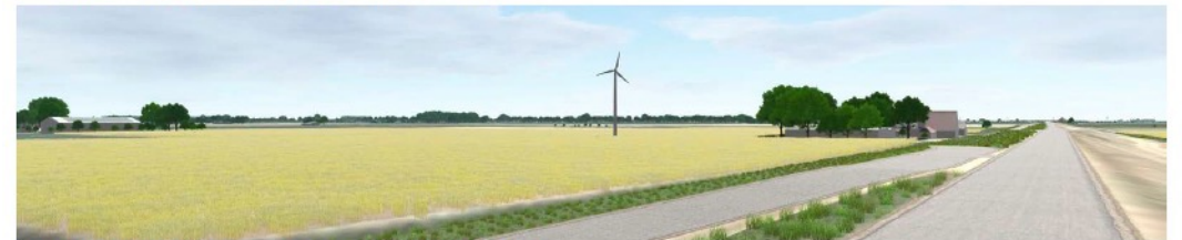
BestWatt – 30 ashoogte, 38 m tiphoogte op 60 meter afstand
