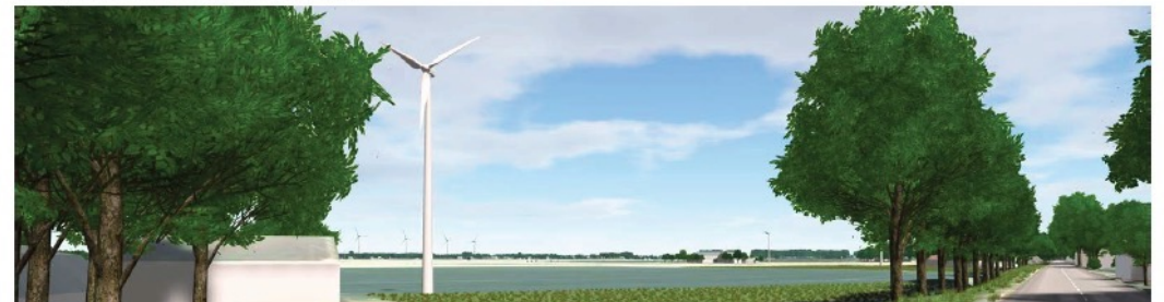
BestWatt - 30 m ashoogte, 38 m tiphoogte
