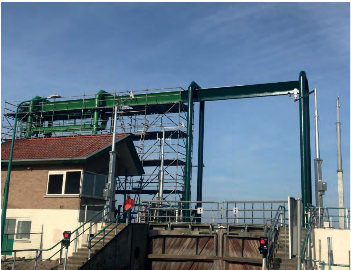
Conservering van de nooddeur-stellage bij de Urkersluis
